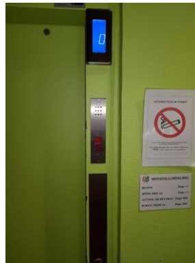
Commande palière du niveau principal
