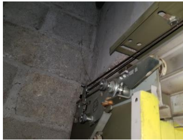
Serrure de porte palière du niveau principal
